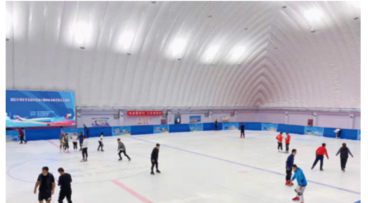
▲ 项目：邢台市滑冰馆其内部
